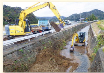
▲河川の浚渫工事
