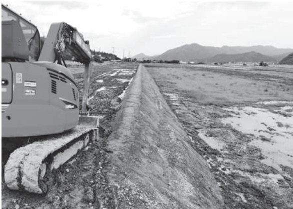
田んぼダム 畦畔の補強
