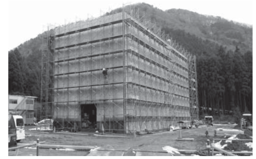
有害鳥獣処理施設工事現場
