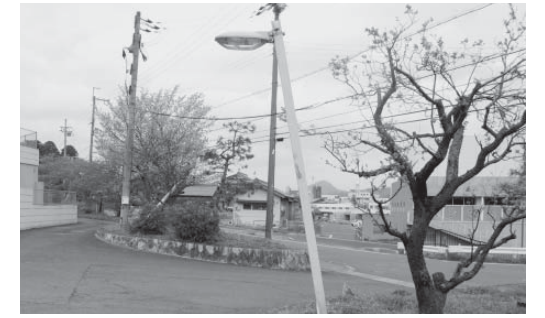
かみなか農村公園照明修繕（市場）
