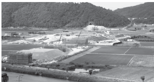
舞鶴若狭自動車道工事風景(生倉)
