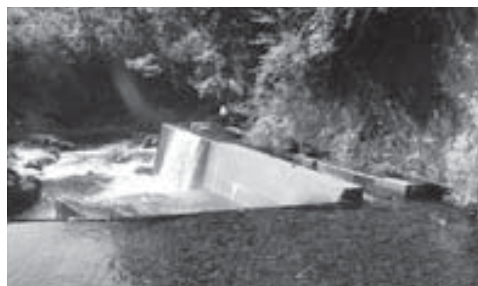
天増川取水口
