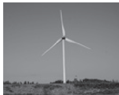
直径92mの風車（あわら市浪松区）
