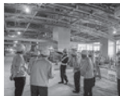
建設中のコンコース
