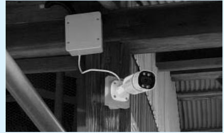
防犯カメラ設置
