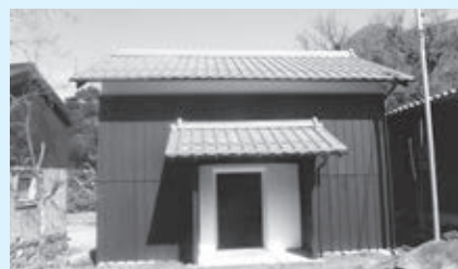
熊川宿 土蔵修理後
