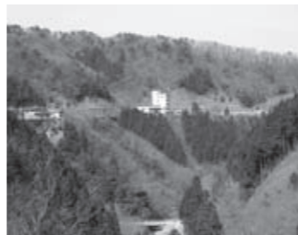
▲河内川ダム工事
