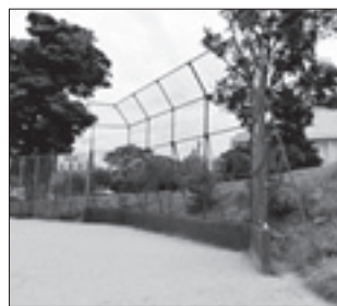
▲がんばる地域交付金 （バックネット改修）
