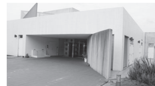
◀パレア若狭/ 太陽光パネル設置場所
