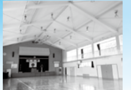
三方小学校体育館吊り天井改修
