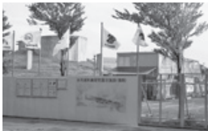
年縞研究展示施設建設現場
