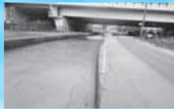
▲観音川(生倉地係) 土砂堆積
