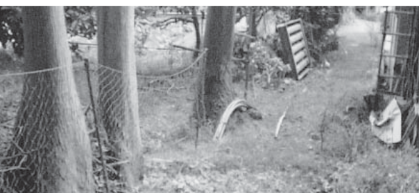
金網柵切れ目箇所（中野木地域）
