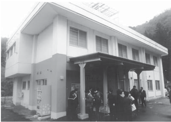
小規模多機能型施設 みさき（神子）
