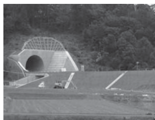
舞鶴若狭自動車道現場
