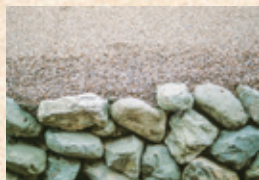
前川石積み護岸との舗装接点付近
