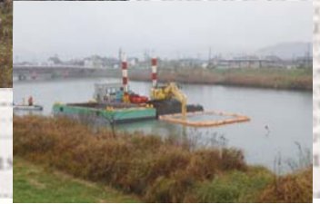
土砂を取り除く しゅんせつ 浚渫作業（小浜市水取）
