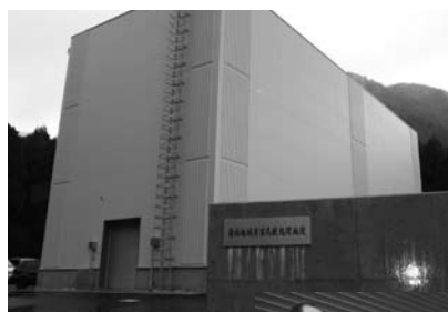
◀完成した 処理施設
