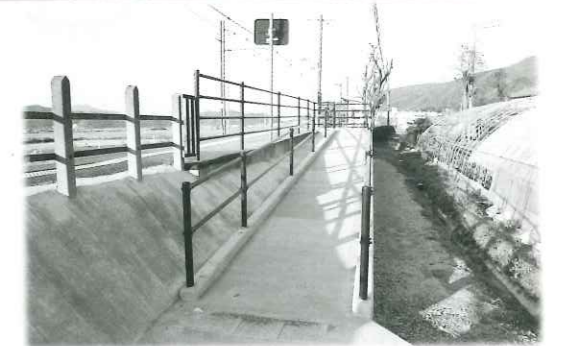
藤井駅に完成したスロープ
