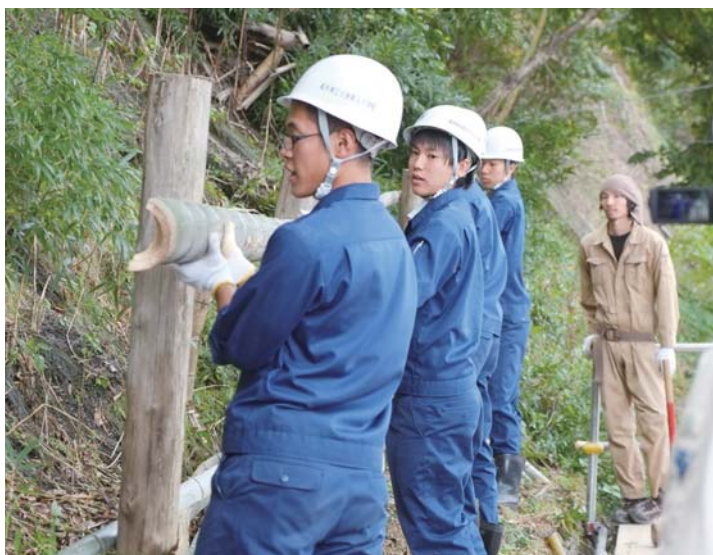
竹のしなりが強く、4人がかりで角度を変えながら押し込んでいます
