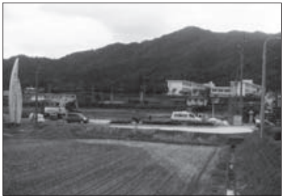
▲ 上瀬住宅団地造成
