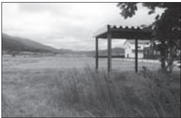
▲ 多目的交流広場整備工事その1（北前川）
