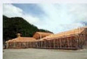
建設中のとばっ子保育園
