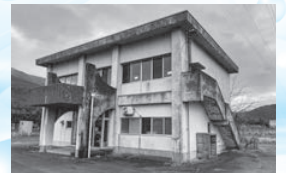
一般会計補正予算 (三方就業改善センター解体工事及び工事監理業務)
