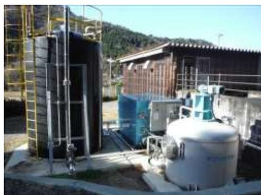
緊急用仮設ろ過装置（シフォンタンク：熊川浄水場）
