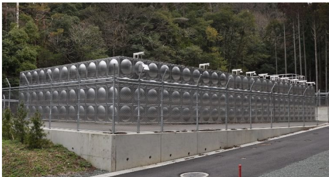
三十三低区配水池 V=600m 3 (2024.6 竣工)
