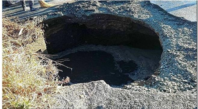
水道管破損による漏水による道路陥没状況
